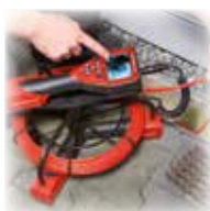
Inspekce potrubí pro svod dešťové vody
