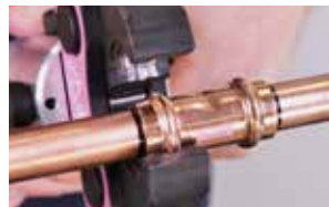
11. Vložte fitinku do lisovacích čelistí
