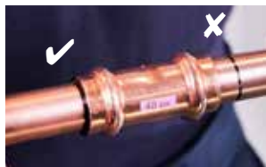
10. Zasuňte trubku zcela do fitinky
