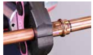
12. Slisujte fitinku schváleným lisovacím nástrojem
