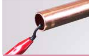
3. Na vnitřní stranu potrubí použijte ruční odjehlovač
